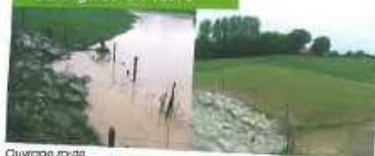
Ouvrage route de Cormont à Frencq qui fonctionne comme une pâture inondable, ouvrage en eau en 2012 et à sa création en 2007.
